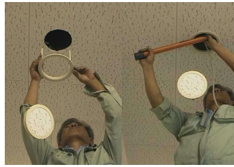
〔現場取付／現場入線〕
