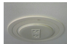
〔電気工事完了〕
